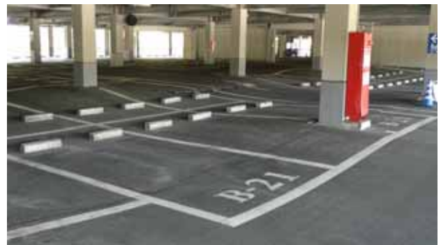
20分後の地震で床盤が一齐に沈下した
